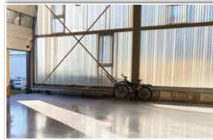
Westfront ist verglast. 10 breit, 5,5 Meter hoch Im Süden das Rolltor für Anlieferungen - ebenerdig.
