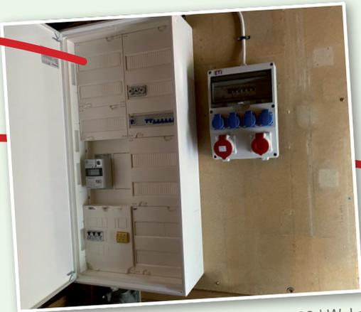
Der neu installierte Stromverteiler der 60 kW-Leitung.
